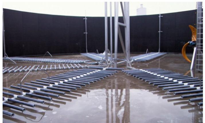
Neue Belüftungsgitter, herauszuheben für Wartung und Reparatur.
