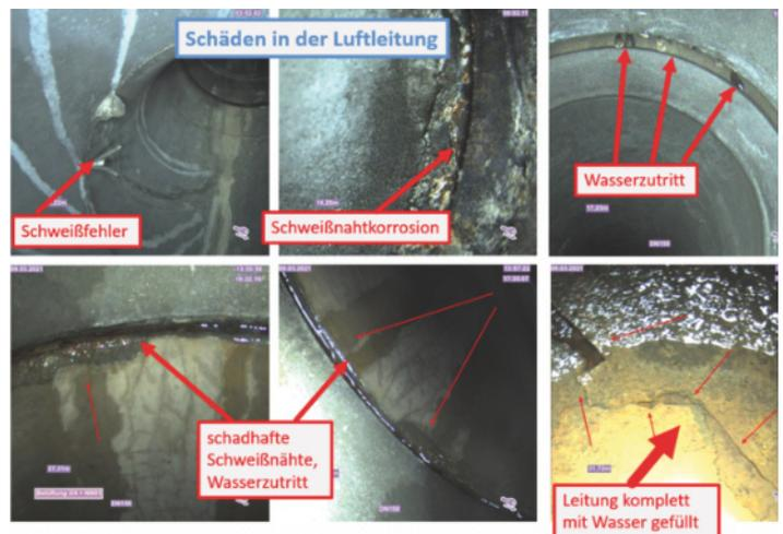
*Ergebnis der Kamerabefahrung der aktuellen Lüftungsleitungen: Massive Schäden (Quelle: Ing.büro Klos,Spalt)*
