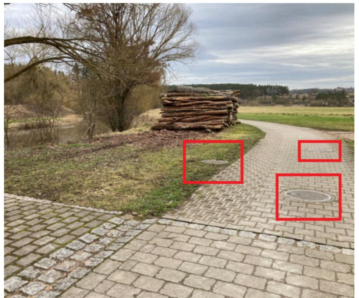
In diesem Bereich befinden sich die unterirdisch verbauten Absperrschieber und Rückschlagklappen.
