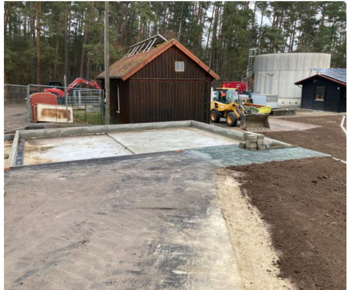
Hier wurde die Aufstellfläche für den Fällmitteltank betoniert.
