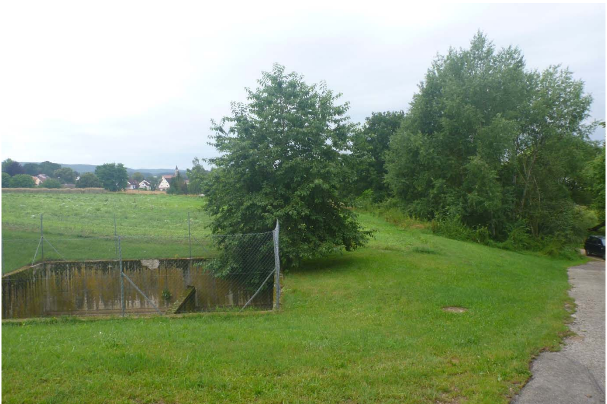
Abb. 8: Absetzbecken im Norden
