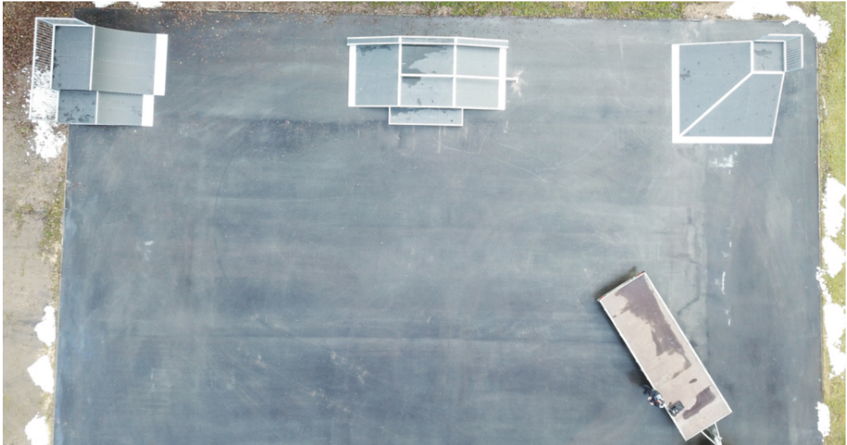
Drohnenaufnahme nach der Montage des ersten Abschnittes im Dezember 2021 (freundlicherweise zur Verfügung gestellt von der Fa. Skateanlagen Schuster GmbH)
