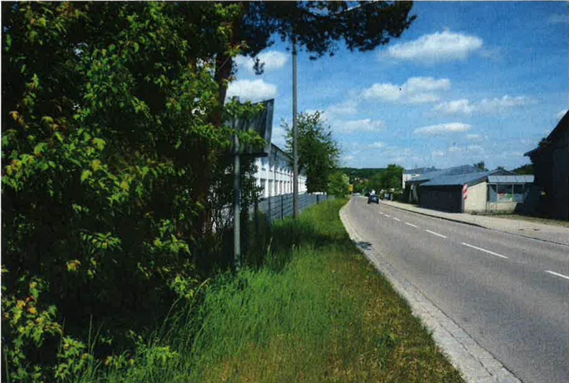
Abbildung 9: Kreisstraße in nördliche Richtung
