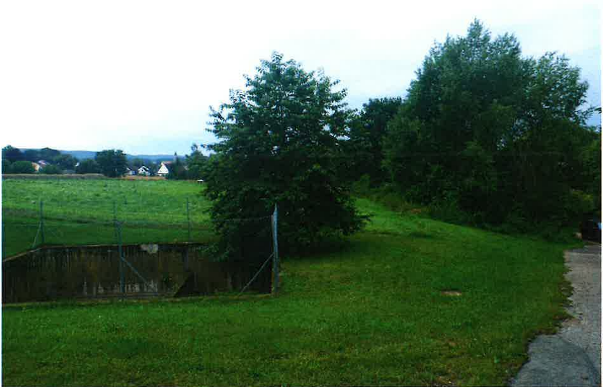
Abb. 8: Absetzbecken im Norden
