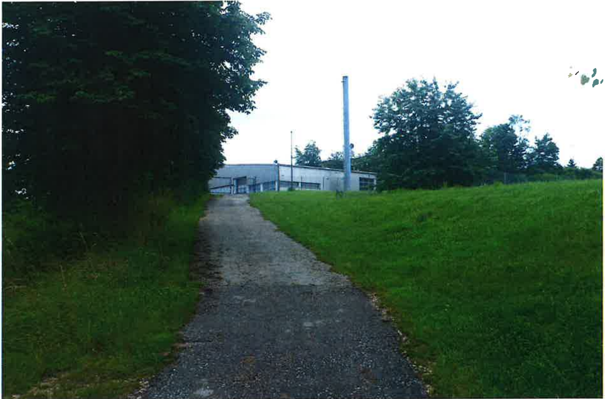
Abb. 9: Weg mit Baumreihe im Norden des Geltungsbereiches
