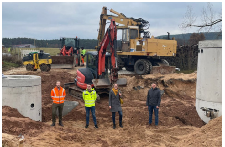
Einbau des Pumpenschachtes im Frühjahr 2022
