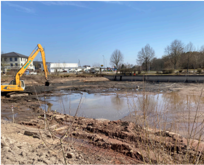
Ausbaggerungs-/Entschlammungsarbeiten am Badeweiher
